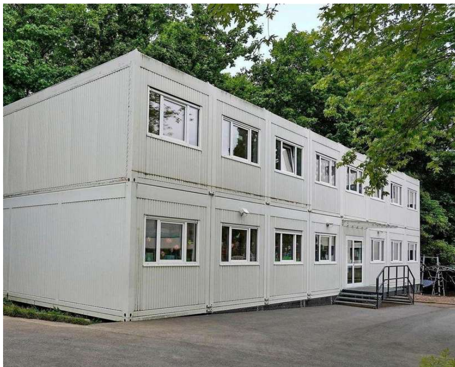
Pavillon scolaire Ecole Le Corbusier, à Champel
