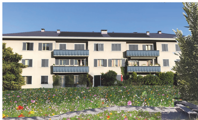
Immeuble 7-9 Hutins rénové entouré d'un espace vert renaturé. (Image de synthèse après rénovation)
